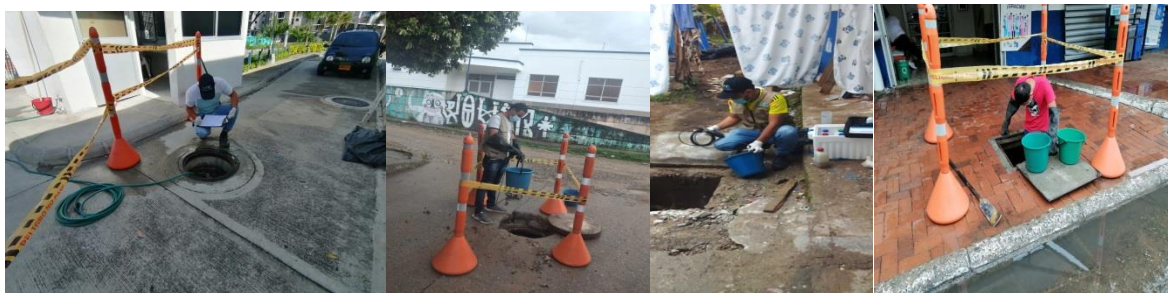
Registro fotográfico muestreo de agua residual
