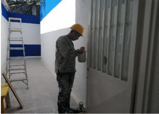
Ilustración 4. Pintura de puertas y ventanas con anticorrosivo
