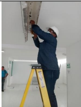
CONSULTA EXTERNA – DESMONTE Y REPARACIÓN LUMINARIAS PASILLOS
