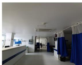
AIRE DE URGENCIAS NO SIRVE
