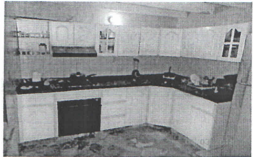
Foto 4. Estado actual cocina
