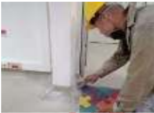
Ilustración 5. Aplicación de pintura vinilo tipo 1 sobre áreas de consulta externa
