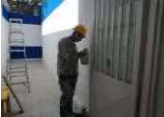
Ilustración 4. Pintura de puertas y ventanas con anticorrosivo
