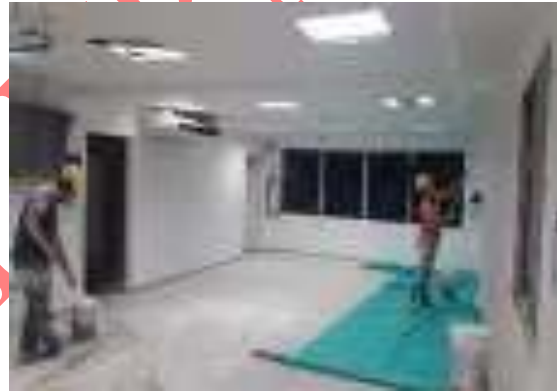
Ilustración 5. Aplicación de pintura vinilo tipo 1 sobre áreas de consulta externa
