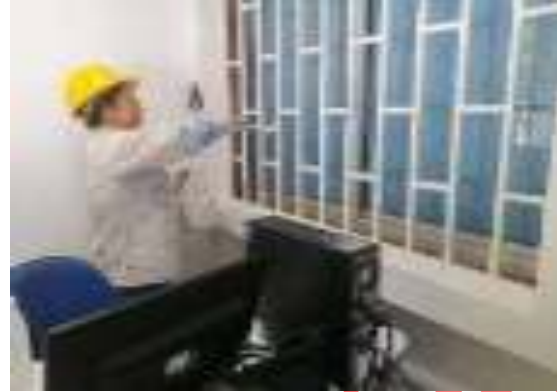
Ilustración 4. Pintura de puertas y ventanas con anticorrosivo
