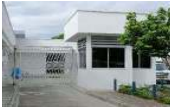
Ilustración 7. Pintura tipo koraza zona garita
