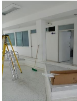
CONSULTA EXTERNA – DESMONTE Y REPARACIÓN LUMINARIAS PASILLOS
