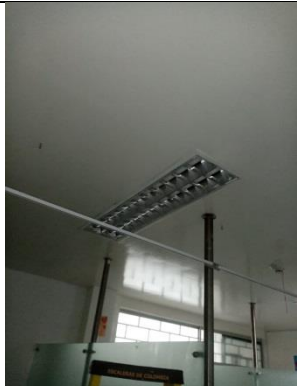
CONSULTA EXTERNA – DESMONTE Y REPARACIÓN LUMINARIAS PASILLOS
