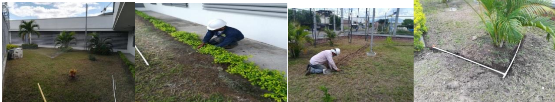
Instalación Sistema de Riego en el centro de salud CANAIMA
