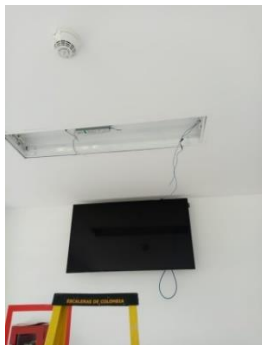
CONSULTA EXTERNA – CAMBIO DE CONTROL PERILLA Y HABILITACIÓN FUNCIONAMIENTO DE GRECA
