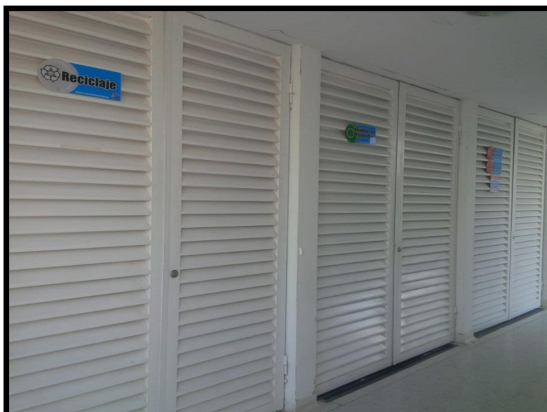
DEPÓSITOS DE RESIDUOS HOSPITALARIOS
