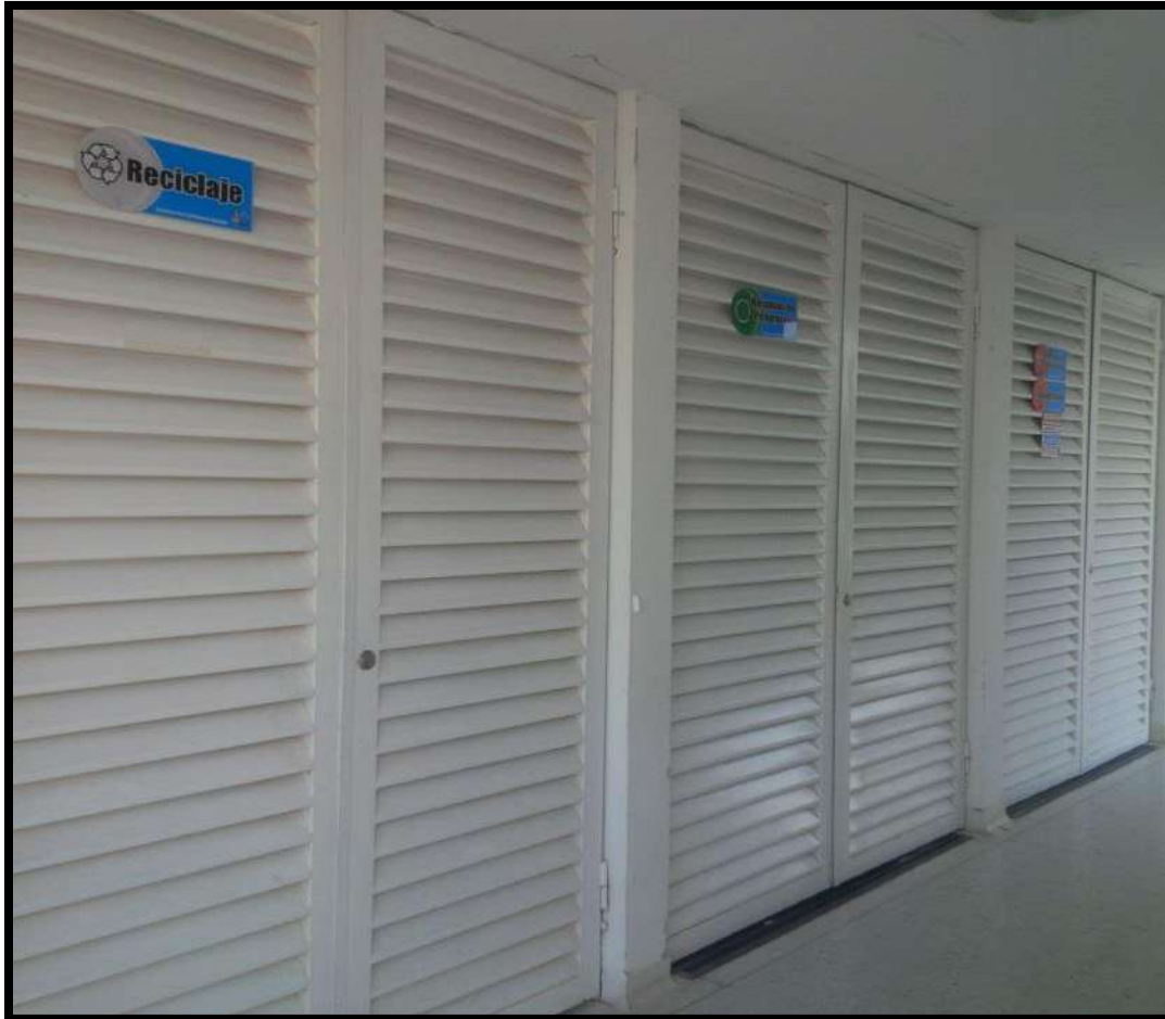
DEPÓSITOS DE RESIDUOS HOSPITALARIOS
